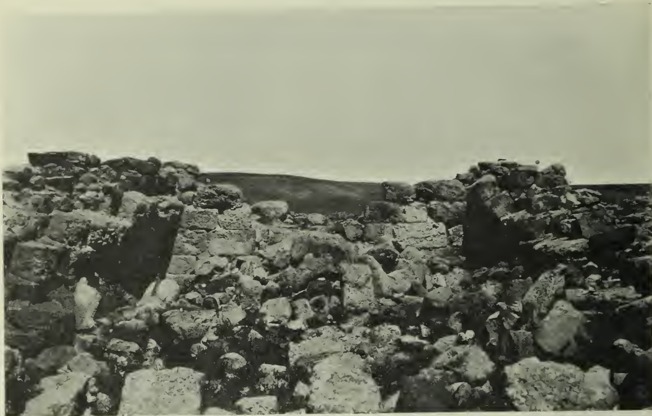
Fig. 590. el-Leğğûn: Turm XXIII von außen.
