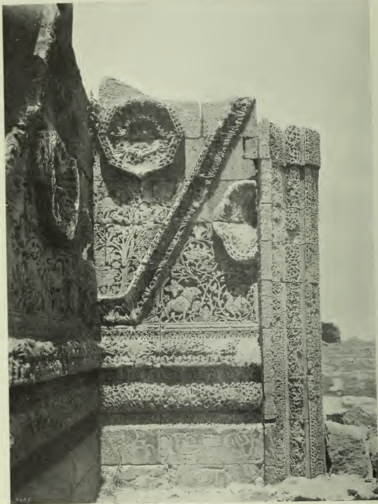
Fig. 741. el-Mešettä: Fassade K'.
