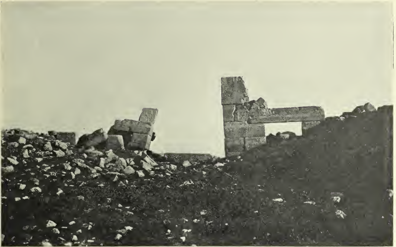
Fig. 592. el-Leğgûn: Porta Principalis sinistra von außen.
