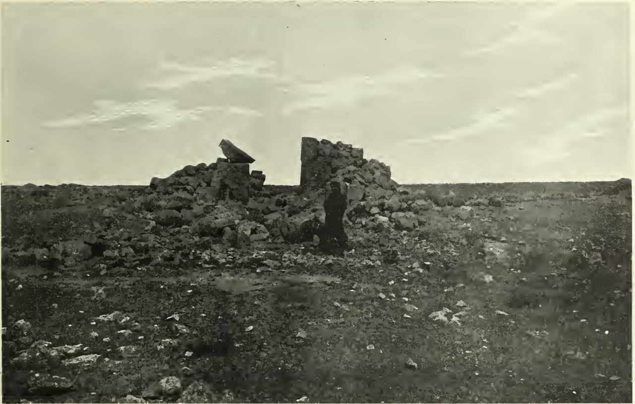
Fig. 661. Hân ez-Zebîb: Zweites Gebäude: Tor von Süden.
