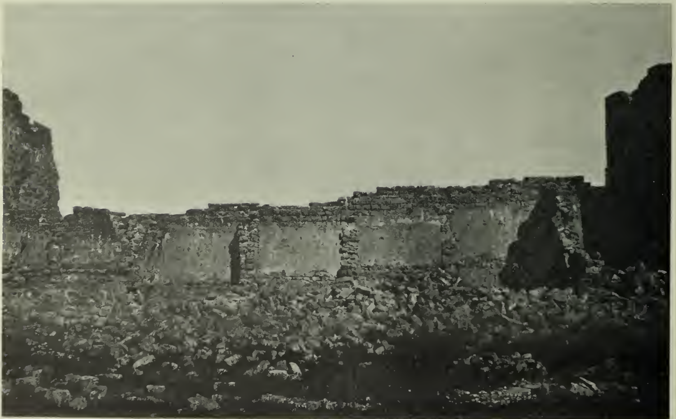
Fig. 628. aşr Bšêr: Nordwestliche Innenwand von Turm I bis Turm II.
