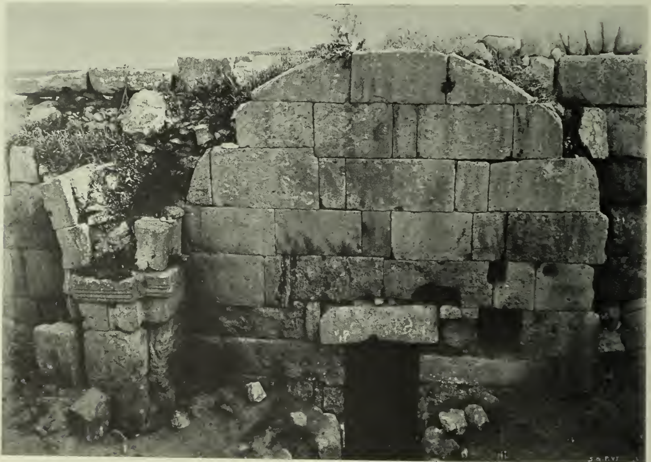
Fig. 679. el-Ḳaṣṭal: Torweg: Südwand von b , mit der Türe vom Zimmer e_1 .
