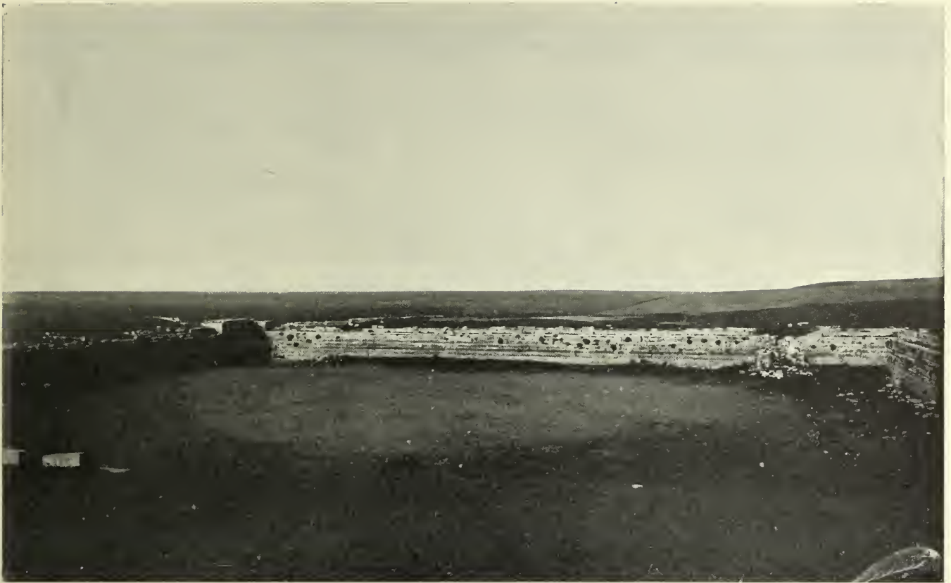
Fig. 674. Zizâ: Cisterne von Westen.
