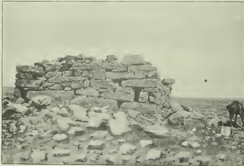
Fig. 613. Ruğûm Rişân: Wartturm 2 h 14 m : Ansicht von Süden.
