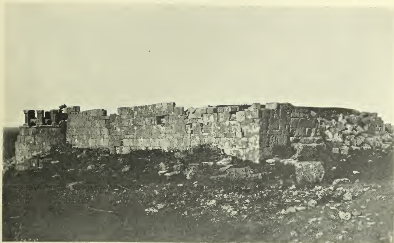
Fig. 682. el-Ğaşal: Praetorium von Südwesten.
