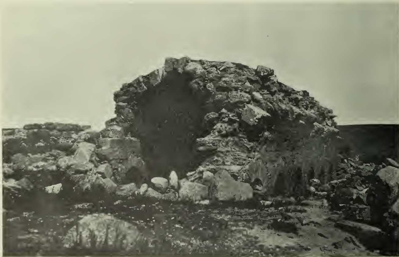
Fig. 771. el-Muwaḳḳar: Kleiner Bau von Nordwesten.
