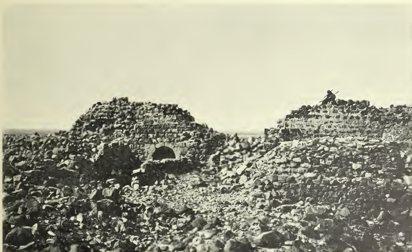
Fig. 565. Da'ġāniya: Wassertor p von innen.
