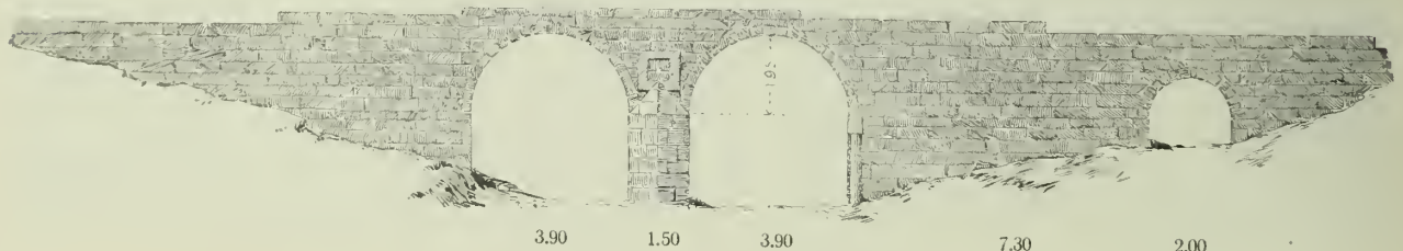
Fig. 573. Brücke bei Ḳal'at el-Heṣâ von Osten. (Do.).
