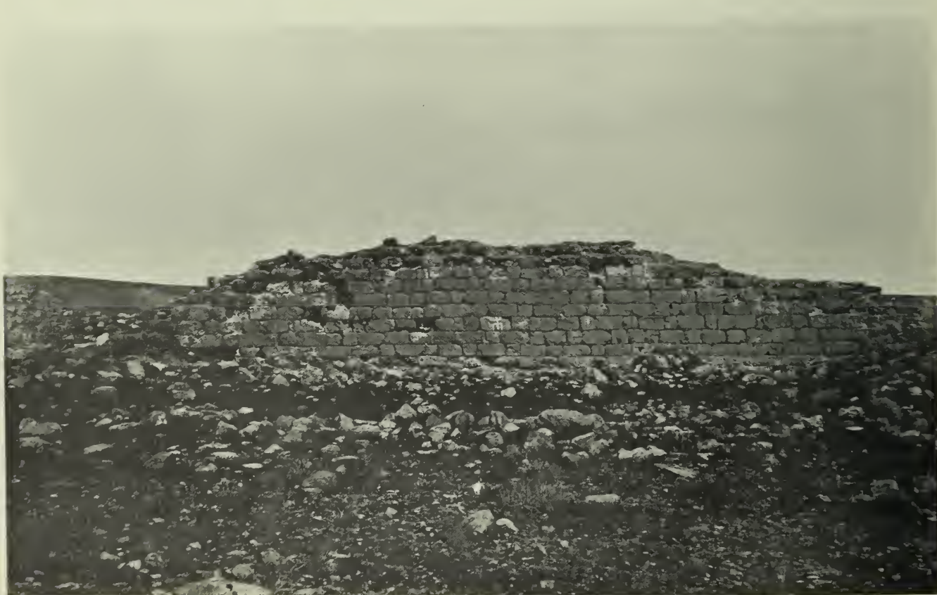
Fig. 591. el-Leğğûn: Mauerstück (Innenseite) östlich von der Porta Principalis sinistra.
