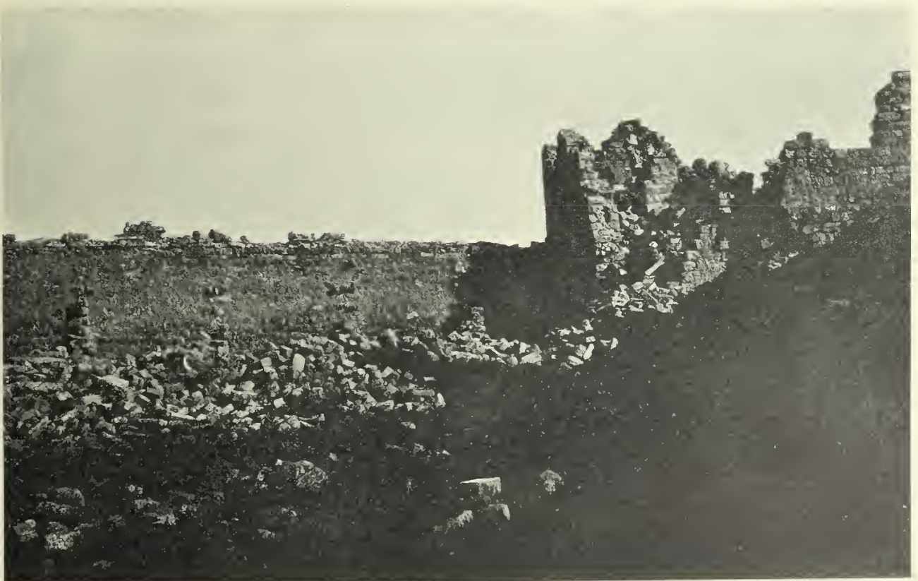
Fig. 630. Kaşr Bşêr: Nordöstliche Innenwand vom Zimmer k bis Turm III.
