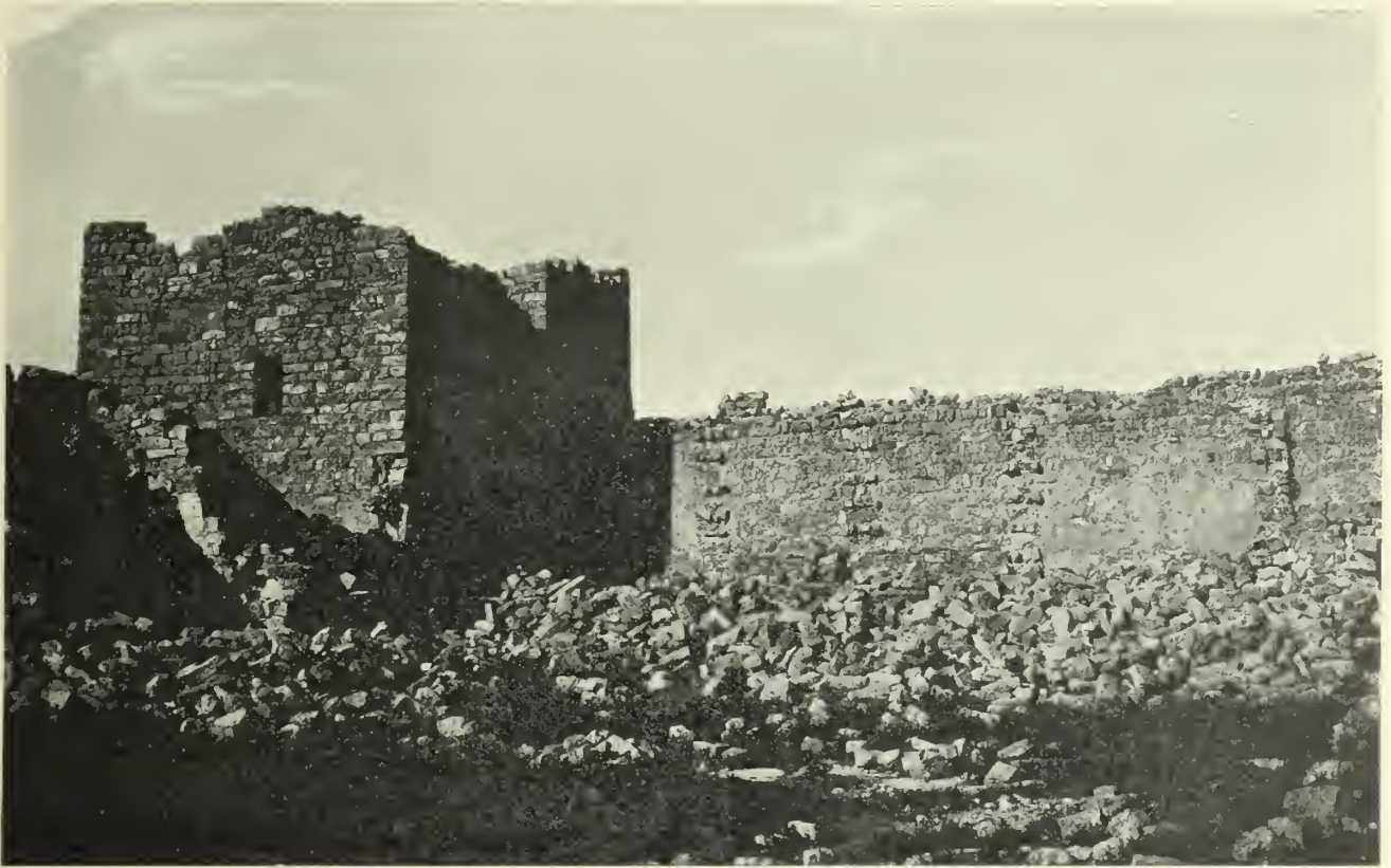
Fig. 629. Kaşr Bşêr: Nordöstliche Innenwand von Turm II bis zum Zimmer k .
