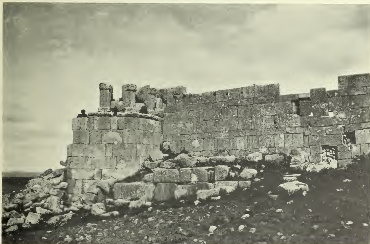
Fig. 683. el-Ğaşal: Turm des Praetoriums von Südwesten.
