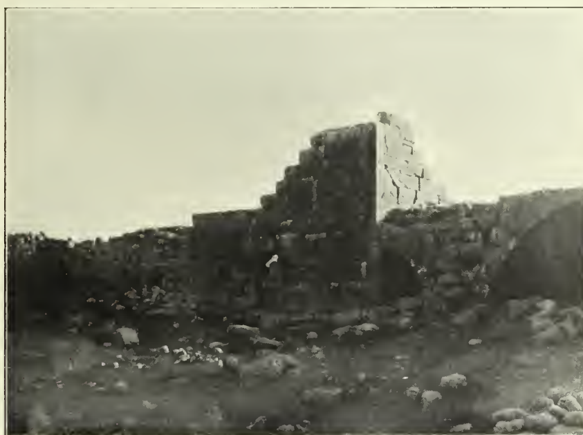
Fig. 672. Zizâ: Teil des südlichen Baues, von Norden.
