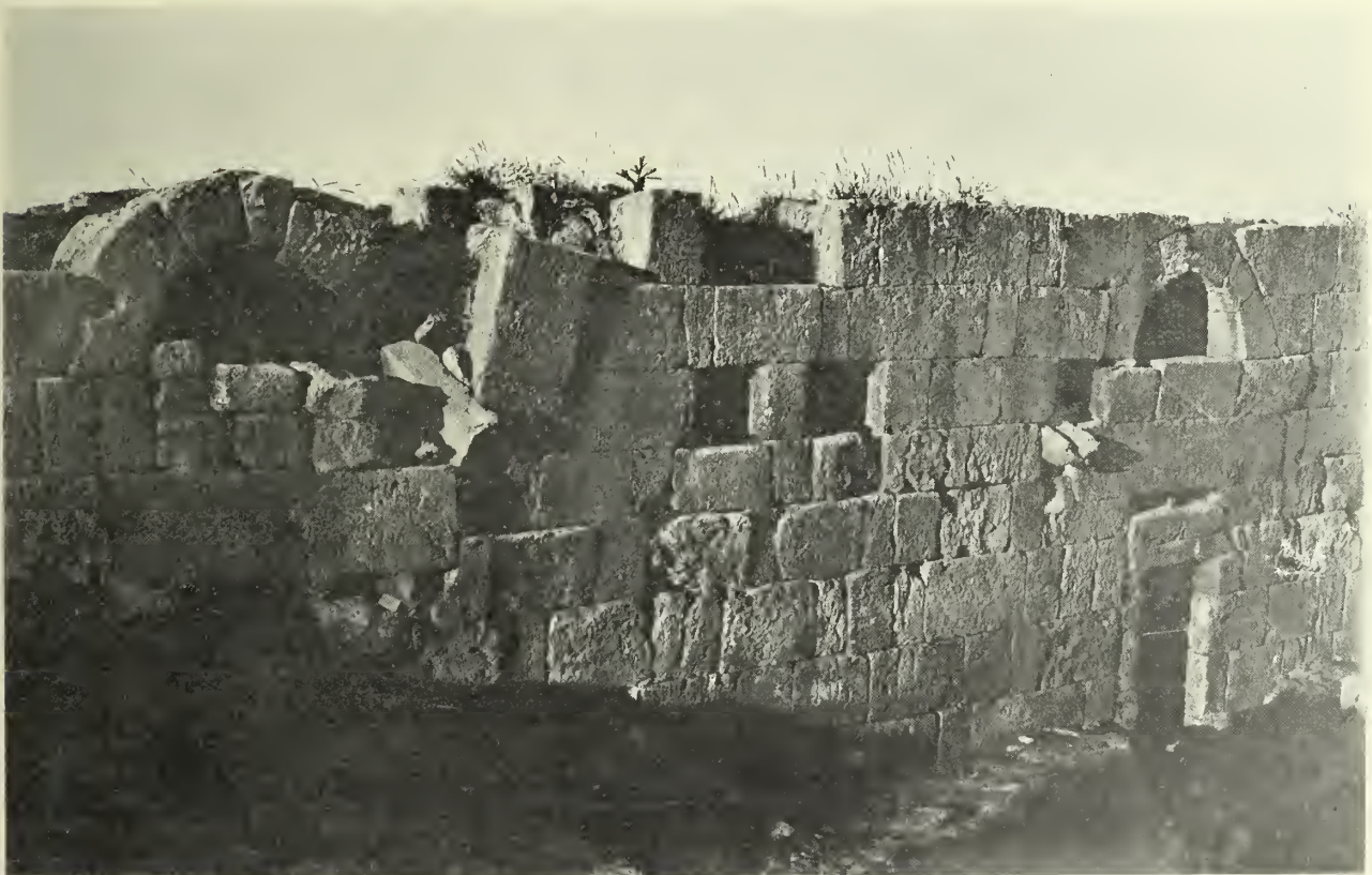
Fig. 680. el-Kaṣṭal: Südwand des Nebenhofes c 1 .
