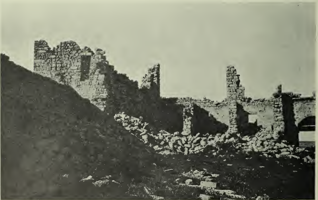
Fig. 632. Ḳaṣr Bšêr: Südwestliche Innenwand von Turm IV bis zum Tor.
