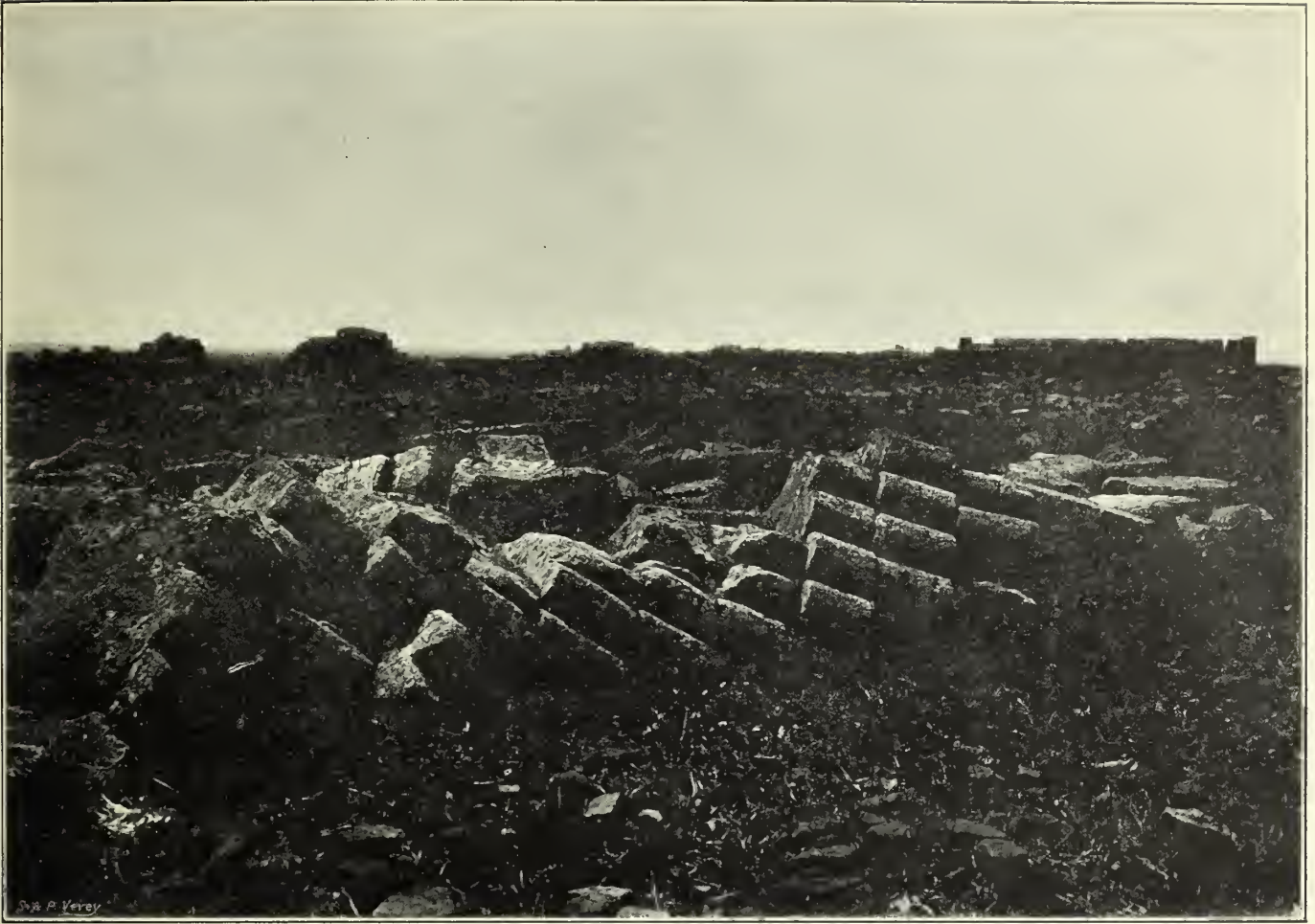
Fig. 709. el-Mešettâ: Hauptbau: Abgestürzter Bogen des äußeren Tores.
