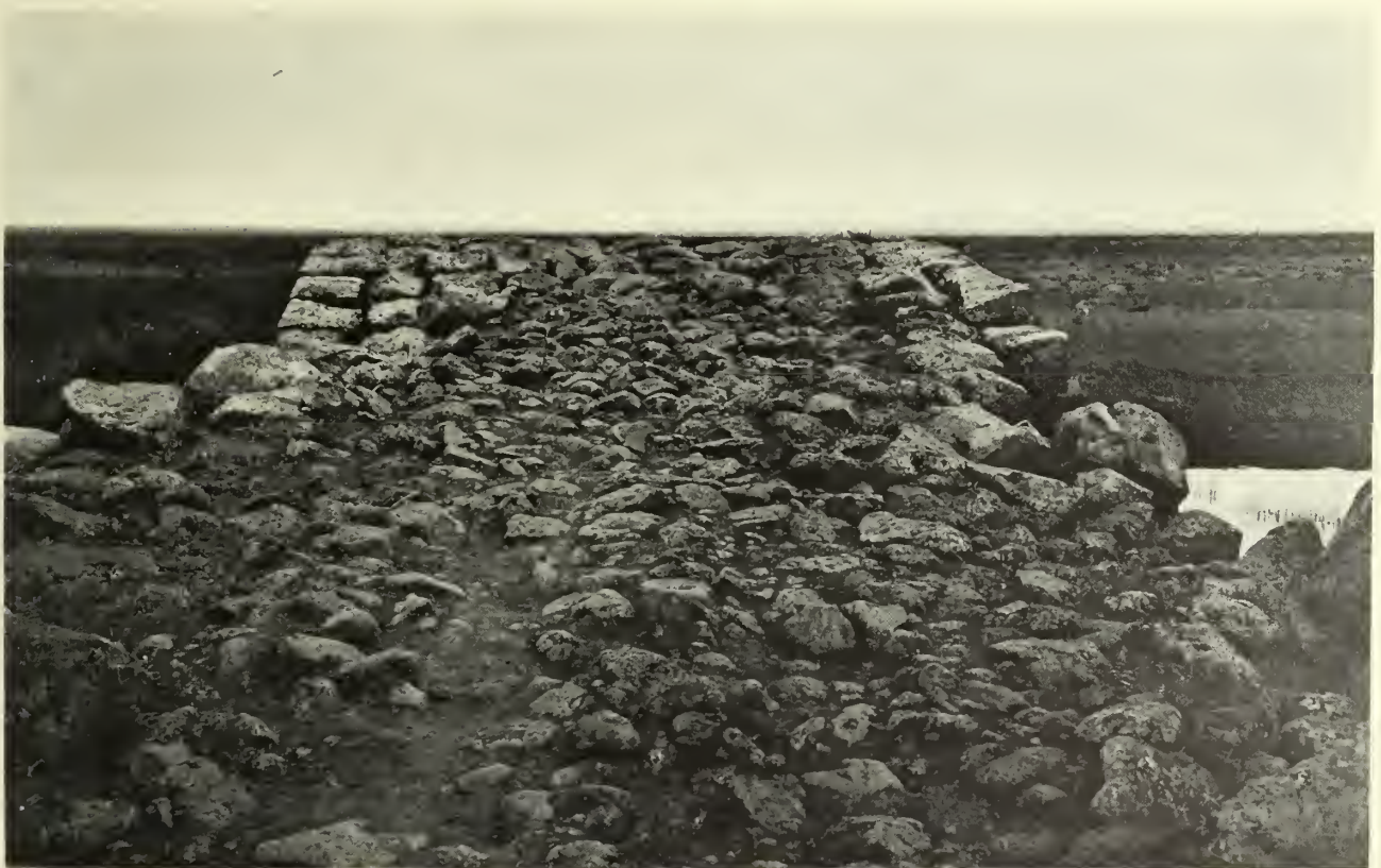
Fig. 855. Wâdi-Zêdi-Brücke: Die darüberführende RS von Westen.
