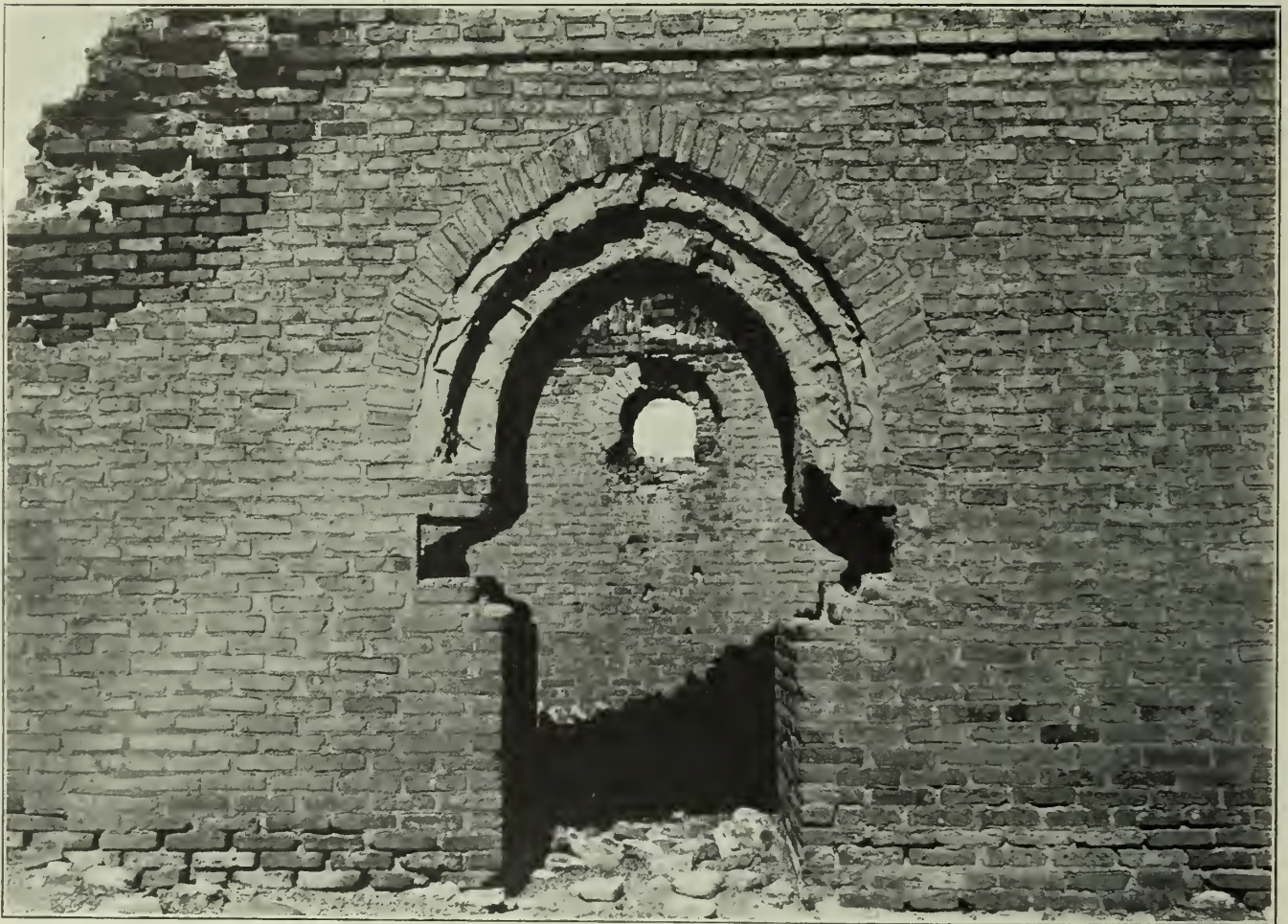
Fig. 720. el-Mešettâ: Hauptbau: Türe des Zimmers p_1 .
