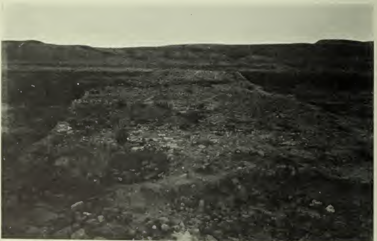
Fig. 570. Römerstraße bei Ḳal'at el-Ḥeṣâ von Süden, beim Übergang über die Brücke.
