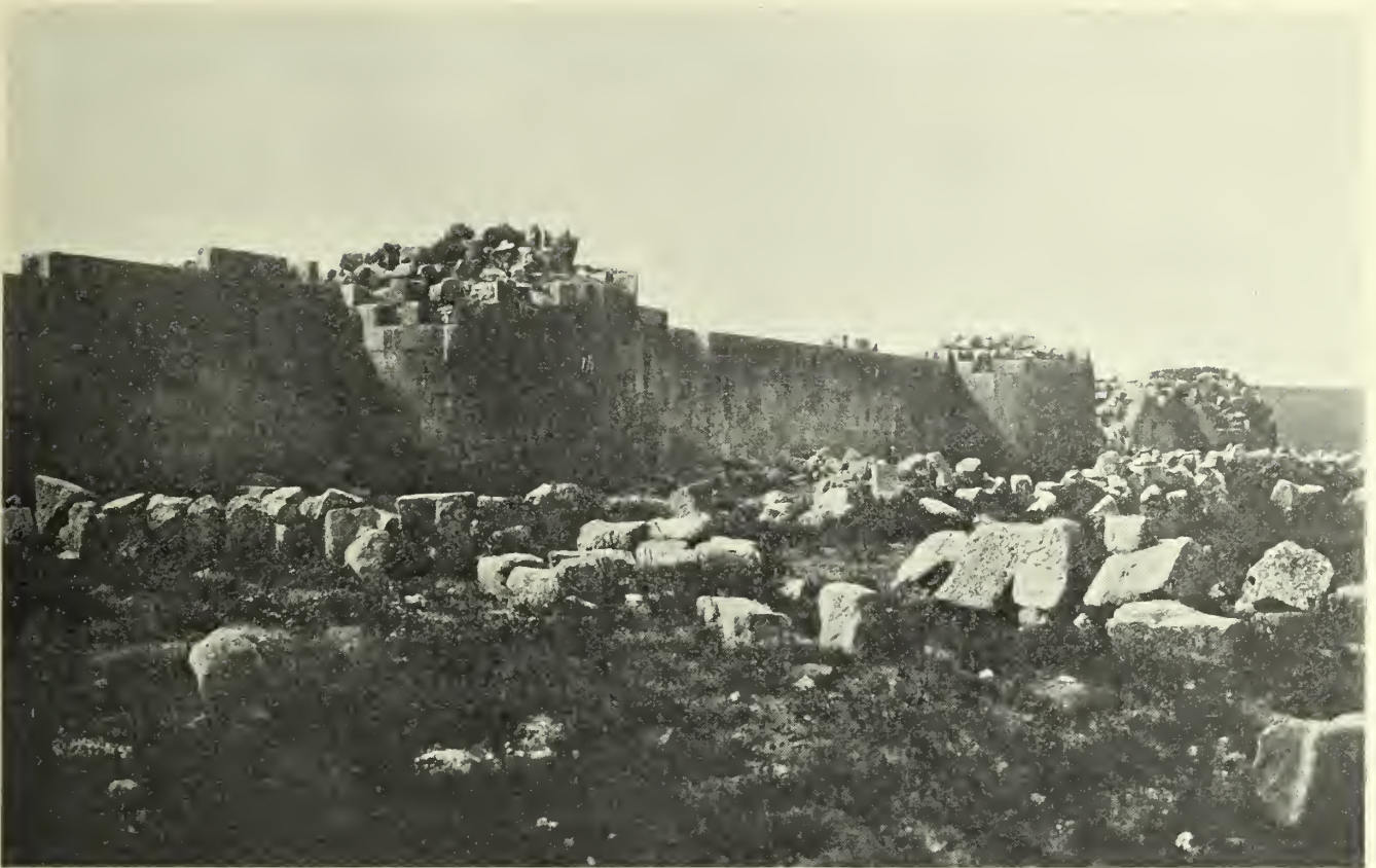
Fig. 689. el-Mešettâ: Außenseite der Ostmauer mit den Türmen T, S und R.
